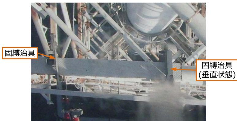
写真3.点検用足場に固縛治具を設置している状況
