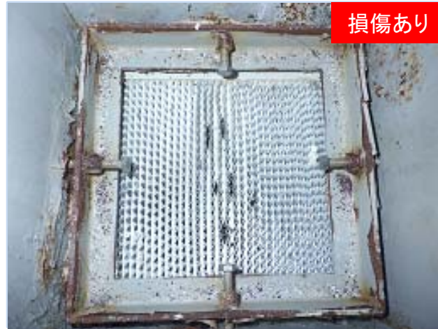
増設ALPS 排水タンク排気フィルタ
