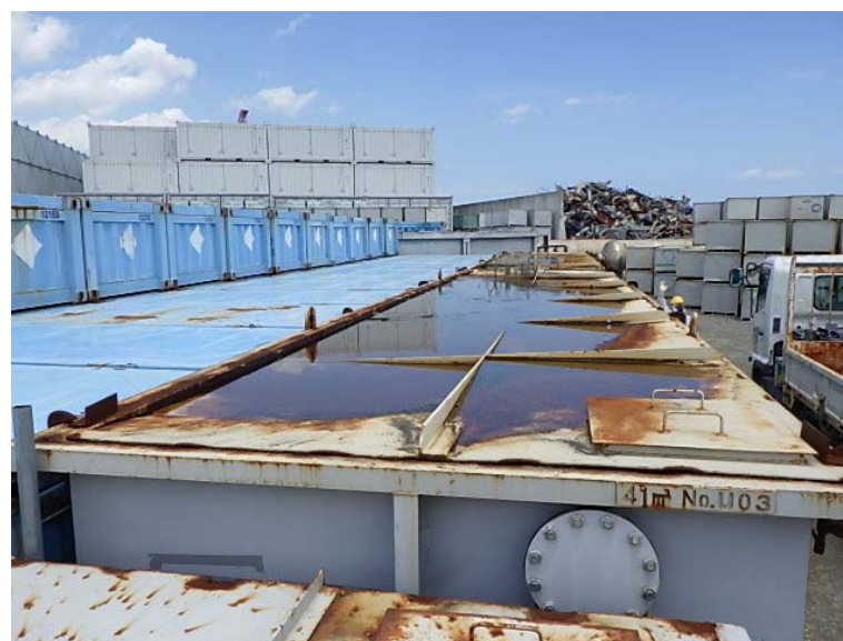
手前ハッチ蓋閉め後 (2021.7.6撮影)
