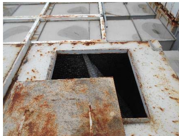
写真1.蓋がずれた状態 (7月9日撮影)
