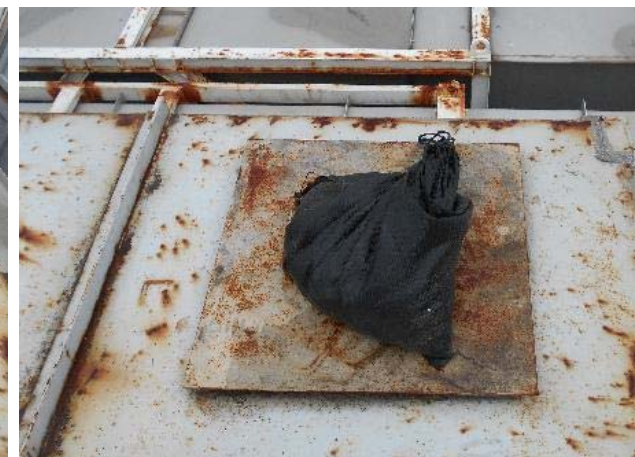
写真2.蓋を閉じ、土嚢設置対策後の状態 (7月9日撮影)
