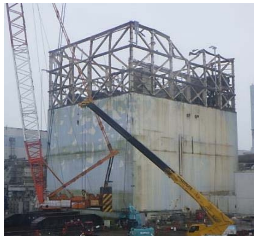
写真2.建屋カバー残置部等 解体作業完了日の状況 (2021年6月19日撮影)
