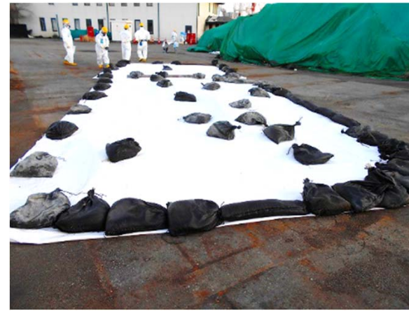
写真2.除去跡への養生(3月24日)
