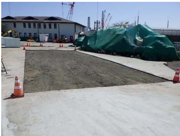
写真3.アスファルトはぎ取り(4月15日) (70 \mu m線量当量率が高い箇所)
