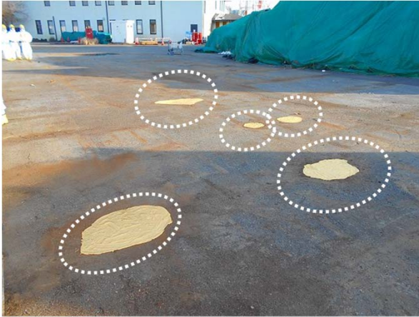
写真1.堆積物除去・除染材塗布(3月24日)
