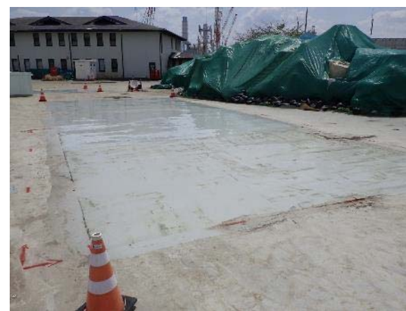
写真4.アスファルト再舗装(4月15日)・塗装(4月16,19日) (4月20日撮影)
