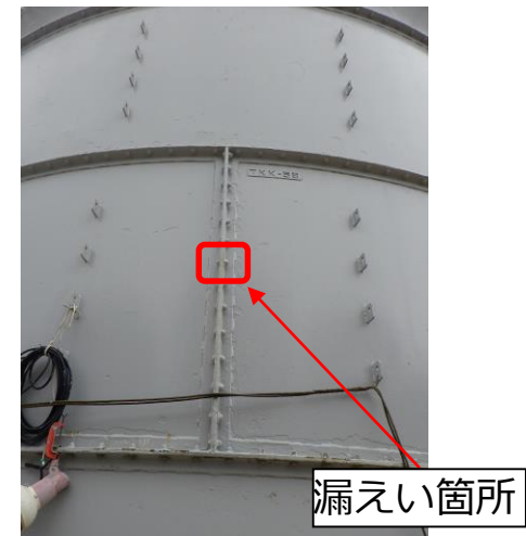
【H4タンク漏えい箇所】
