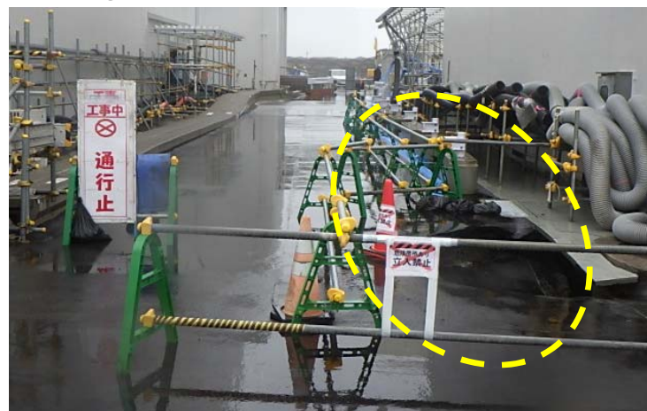
② サイトバンカ建屋北側道路
