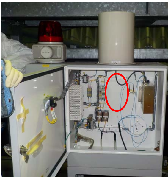
図1.エリア放射線モニタ検出器収納箱 (地震前に撮影、丸部分に当該ヒューズ有り)
