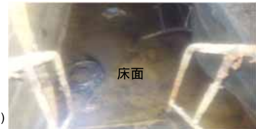
4号機タービン建屋 床面
