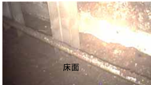
3号機廃棄物処理建屋 床面
