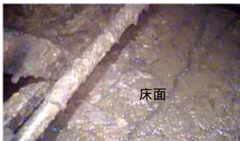
3号機タービン建屋 床面
