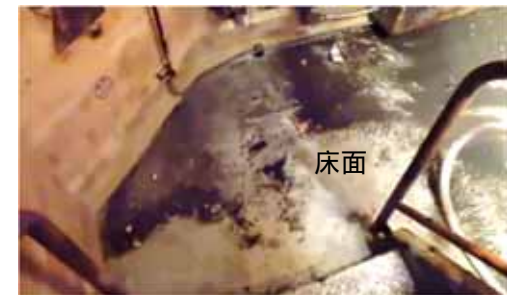
4号機原子炉建屋 床面
