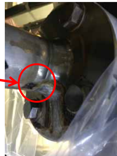
漏えい範囲： 約0.3m×0.1m×深さ1mm（堰内）
