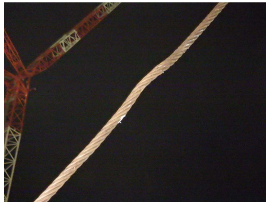
【鉄塔解体装置吊りワイヤー状況】
