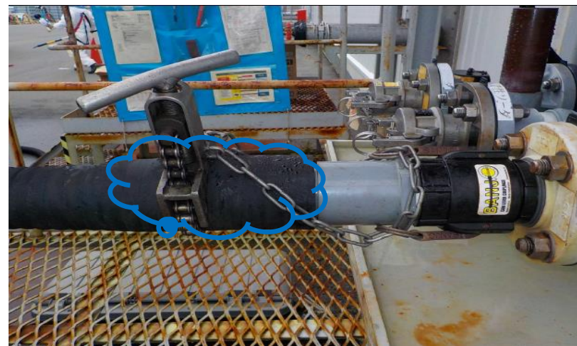
漏えい箇所(ホース外れ)
