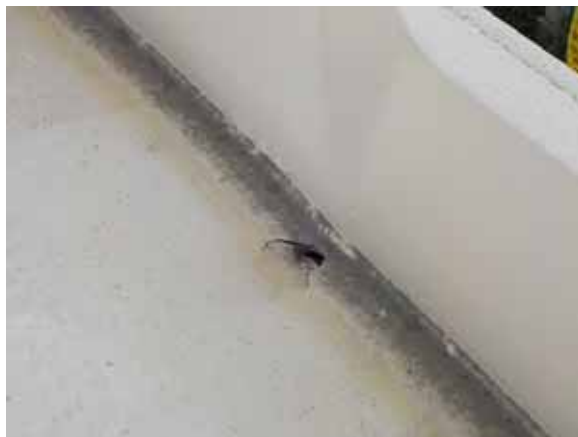
タンク天板損傷箇所
