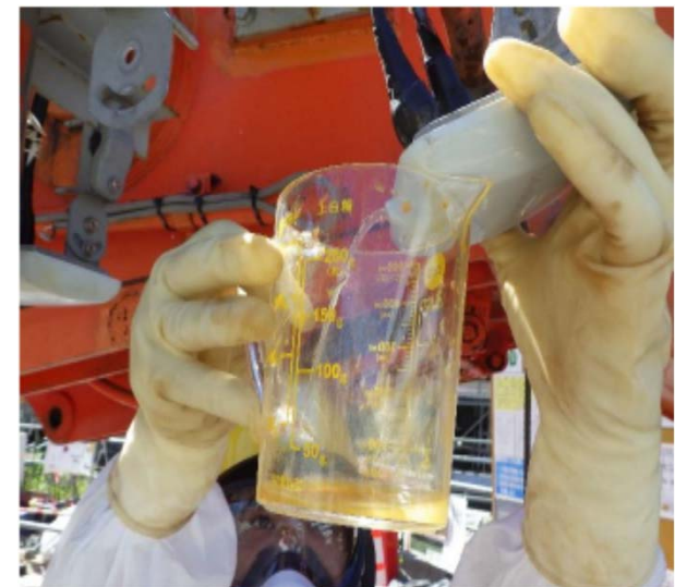
【写真：アンテナ水抜き状況】
