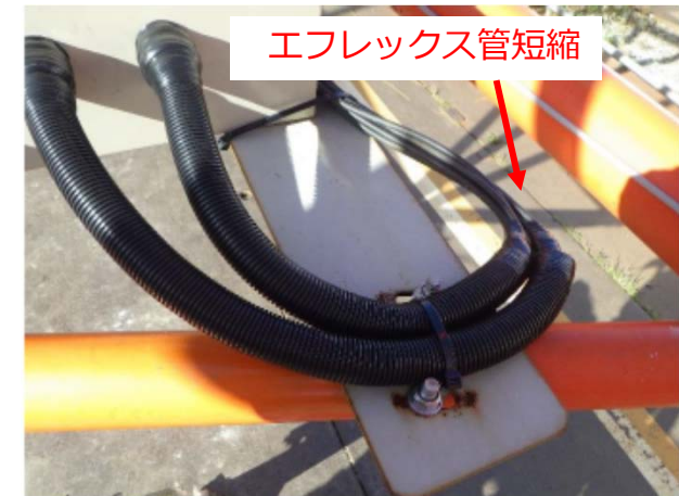
【写真：エフレックス管敷設状況 対策後】
