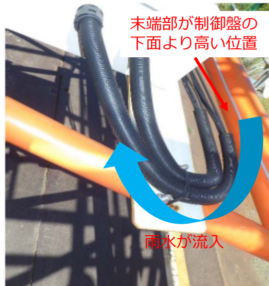
【写真：エフレックス管敷設状況 対策前】
