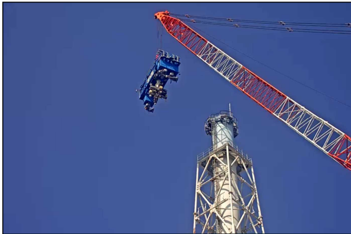
【写真①】 解体装置の設置状況 (8月1日)
