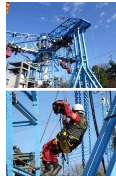
切断作業の訓練状況
