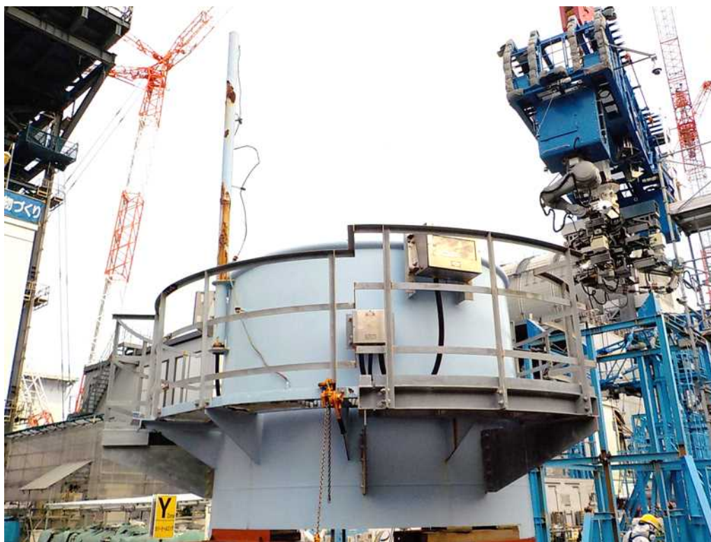
【写真⑨】 解体した部材
