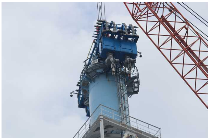
【写真⑤】切断作業状況・外側(9月1日)
