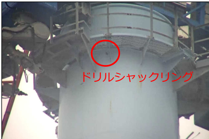
【写真③】 ドリルシャックリング設置状況(8月7日)
