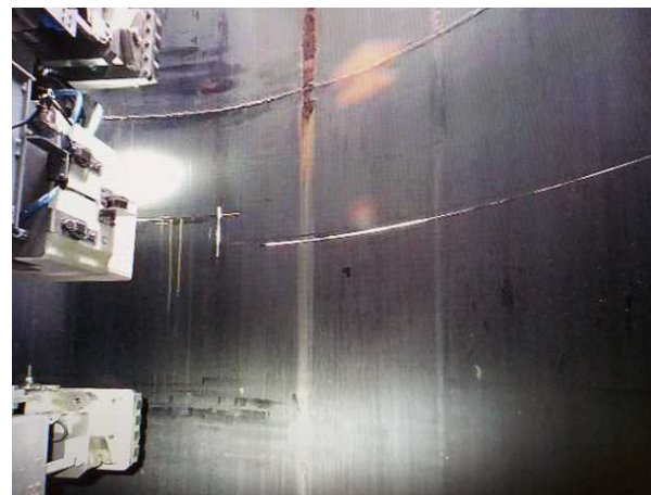
【写真⑥】切断作業状況・内側(9月1日)
