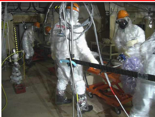
PCV外部 (X-6ペネ) 前での作業
