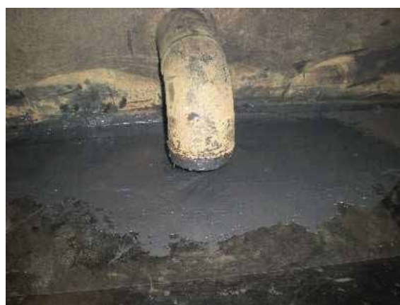
底板ドレン配管近傍
