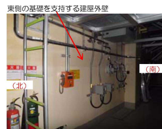
東側の基礎を支持する建屋外壁
