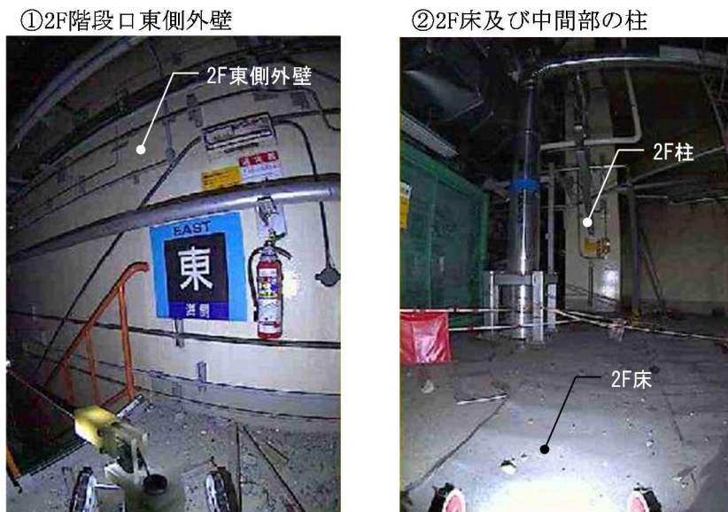
図-2.4(1) 建屋内状況写真（2階）
