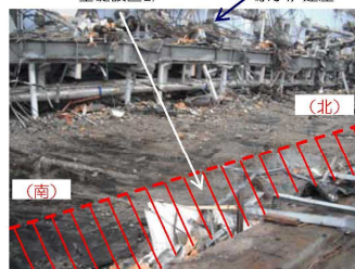
基礎設置部 (東側、外部)
