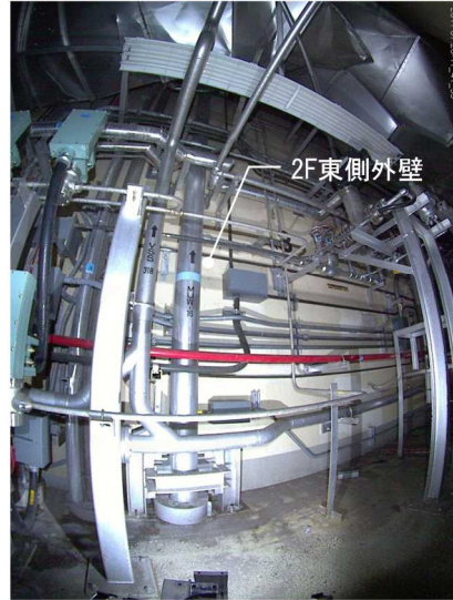
④2F東側外壁
