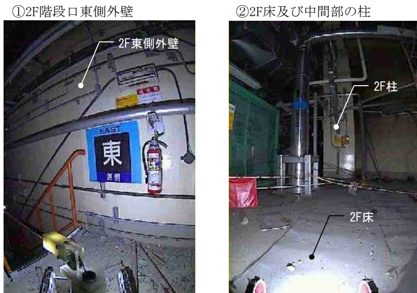
図-2.4(1) 建屋内状況写真（2階）
