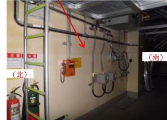
⑤基礎設置部 (東側、内部)
