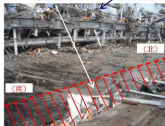
④基礎設置部 (東側、外部)
