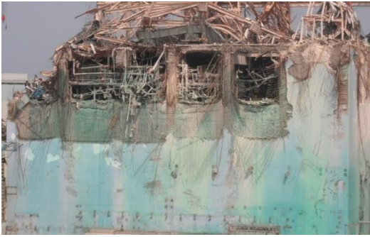
②東側壁面
