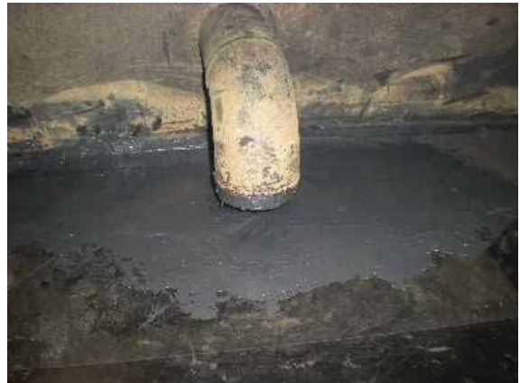
底板ドレン配管近傍
