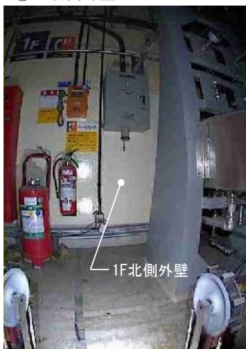
①1F北側外壁
