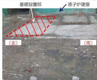
③基礎設置部 (西側)
