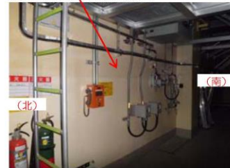
⑤基礎設置部 (東側、内部)
