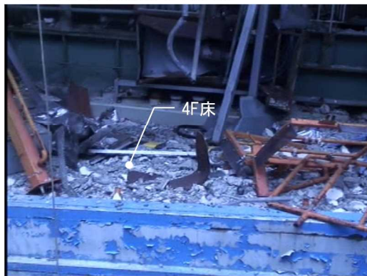
⑥4F床 (大物搬入口北側)
