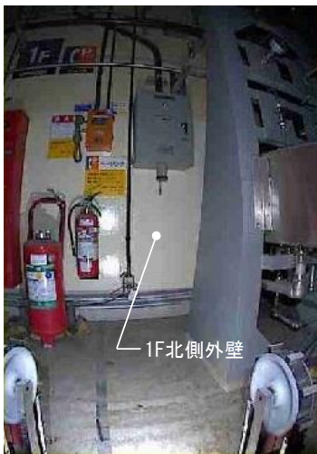
①1F北側外壁
