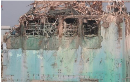
②東側壁面
