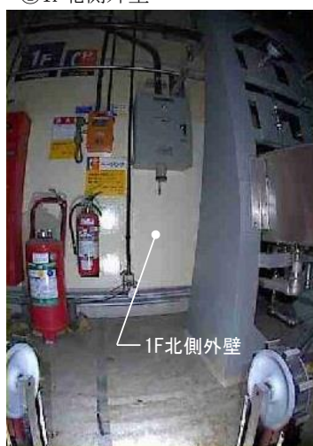
①1F北側外壁
