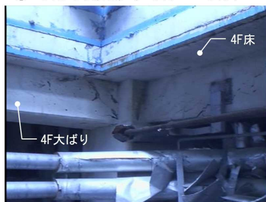
②4F大ばり交差部（R6通り×RF通り）
