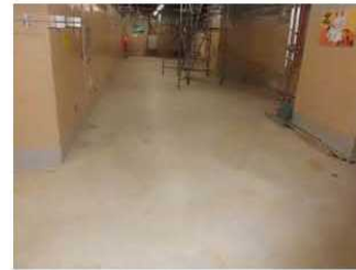
地下1階 (撮影日: 平成24年12月9日)
