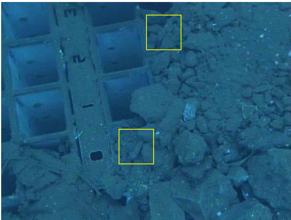
CUW ハッチ落下箇所
