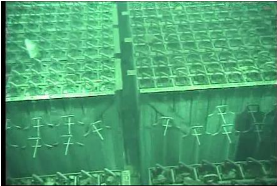
図6-2 4号機SFP内の状況（その2）
