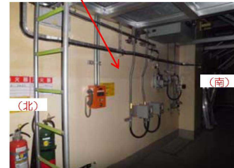
⑤基礎設置部（東側、内部）
