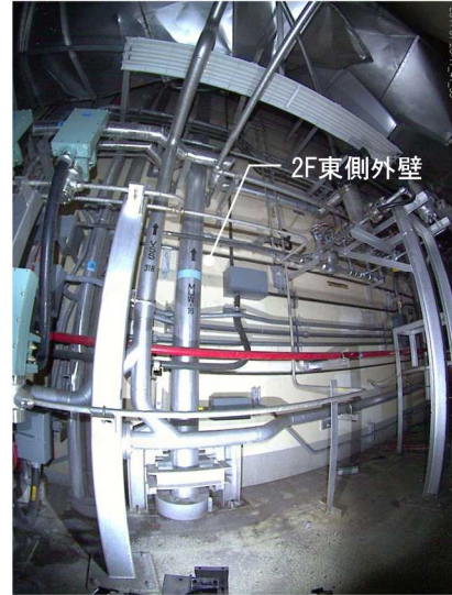
④2F東側外壁
