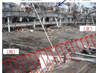
④基礎設置部（東側、外部）
