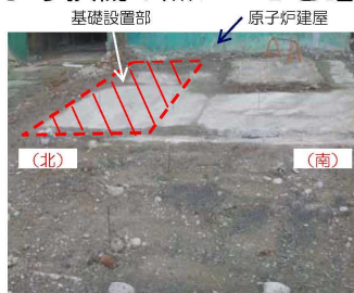
③基礎設置部（西側）
