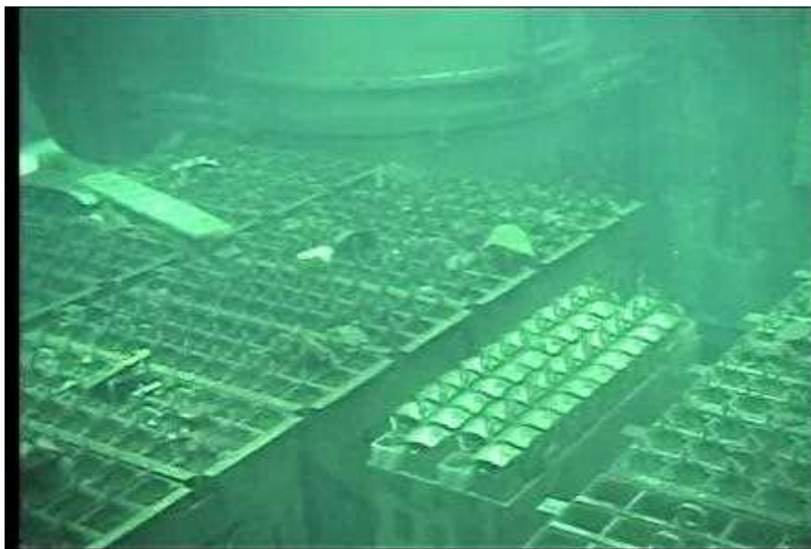
図6-1 4号機SFP内の状況（その1）
