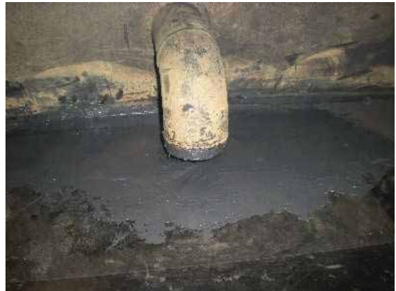
底板ドレン配管近傍
