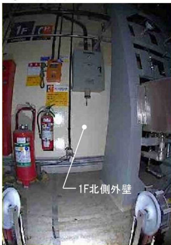
①1F北側外壁
