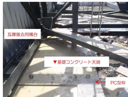
瓦礫撤去用構台東側基礎部 コンクリート打設
