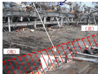
④基礎設置部 (東側、外部)
