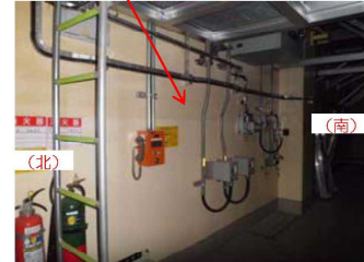
⑤基礎設置部 (東側、内部)
