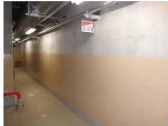
1階 (撮影日: 平成24年12月9日)
