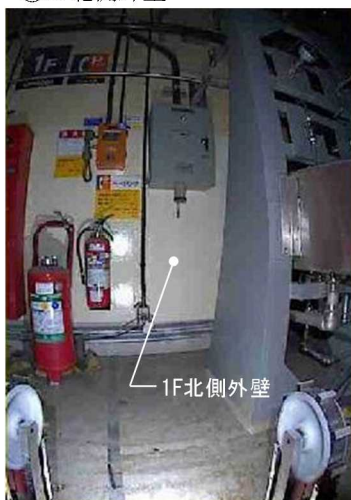
①1F北側外壁
