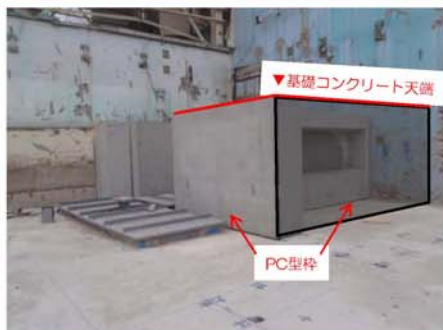
瓦礫撤去用構台西側基礎部 PC型枠設置
