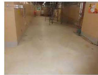
地下1階 (撮影日: 平成24年12月9日)
