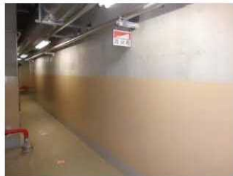
1階 (撮影日: 平成24年12月9日)
