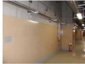
2階 (撮影日: 平成24年12月9日)
