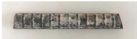
No.3（腐食グレードI）
