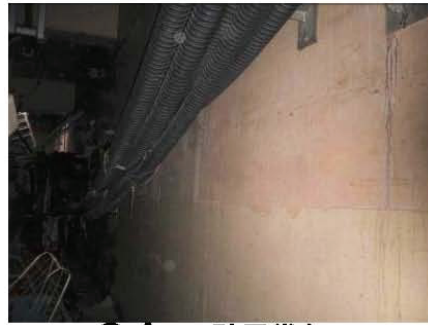
②プール壁異常なし
