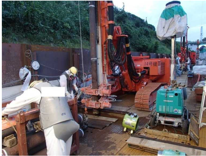
図-4 ボーリング削孔（イメージ）
