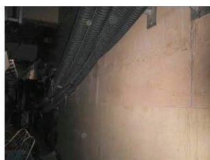
②プール壁異常なし
