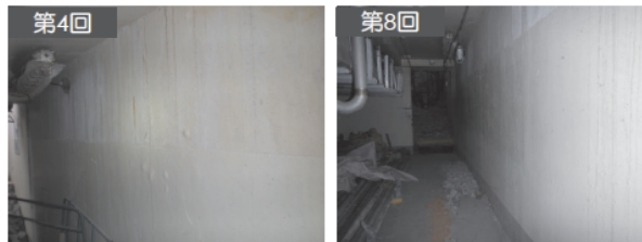
【使用済燃料プール側壁(3階)のひび割れ状況】
