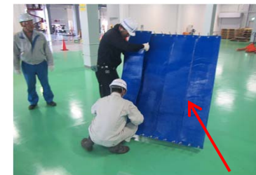
モックアップでの習熟訓練（鉛板設置）
