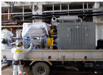
高圧ポンプユニット設置作業
