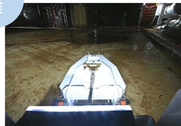
遠隔除染装置による除染
