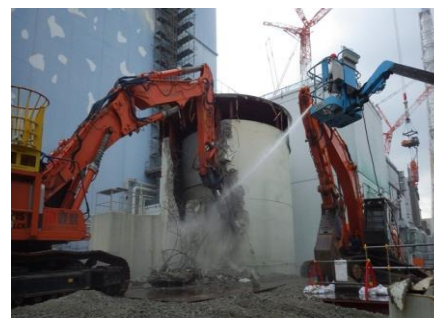
廃液サージタンク解体中
