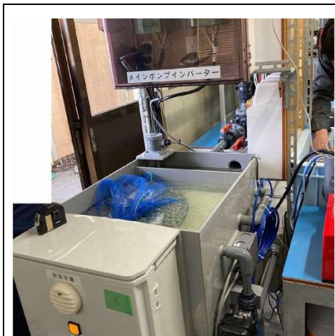
飼育訓練水槽に組み込んだ脱窒槽
