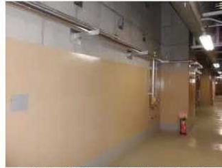
2階 (撮影日: 平成24年12月9日)
