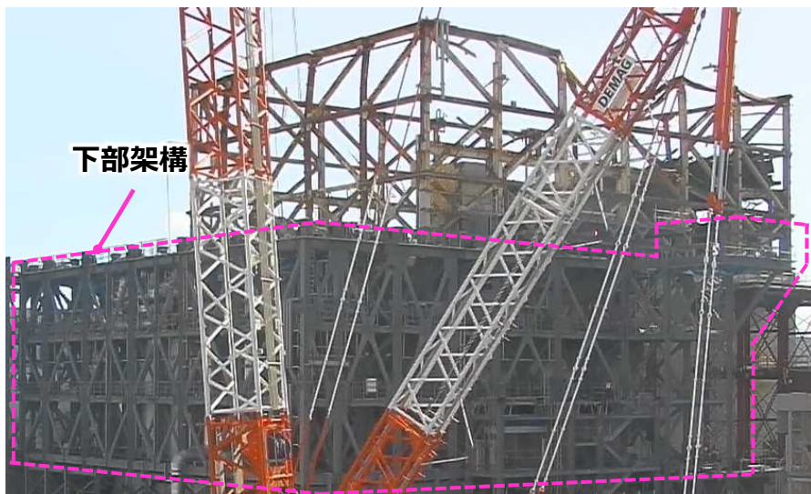
現場状況（北西面） （撮影：2024年1月24日）
