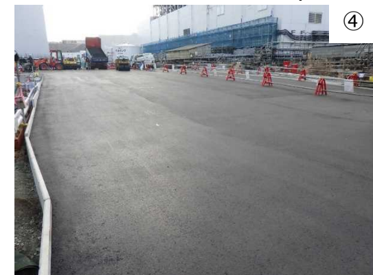
3号機側から4号機側を臨む。 (2023.1月末完了)
