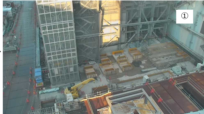
2号機燃料取り出し構台設置に合わせてフェーシング実施(2023.6月完了) (フェーシング上部を一時的に埋め戻し)
