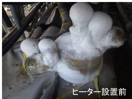
ヒーターによる凍結管着氷防止対策イメージ（他エリアの実績：炉注水配管保護のため設置）
