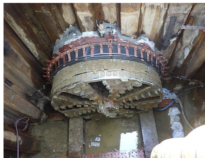
写真① 上流側推進管内部
