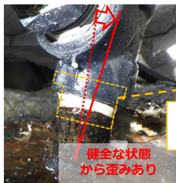
①凍結管継手部の目視確認
