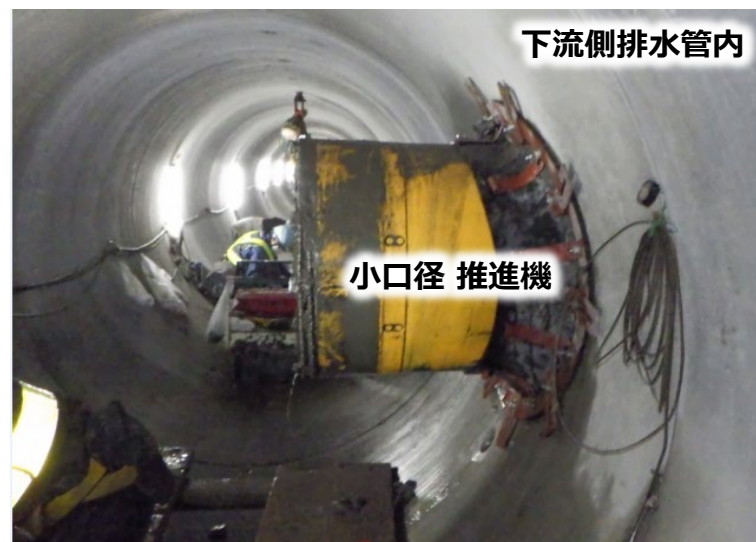
写真⑤ 小口径_本管接続
