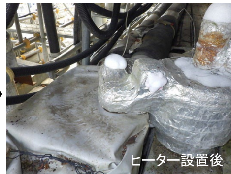
ヒーターによる凍結管着氷防止対策イメージ（他エリアの実績：炉注水配管保護のため設置）
