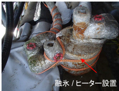
ヒーターによる凍結管着氷防止対策イメージ（他エリアの実績：炉注水配管保護のため設置）
