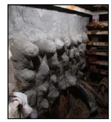
①1号機共通配管トレンチ貫通箇所
