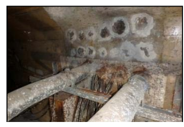
②2号機取水電源ケーブルトレンチ貫通箇所
