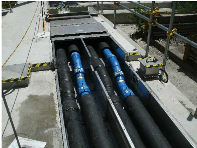
新規PE管施工状況
