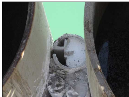
【継手部写真（モルタル充填後）】
