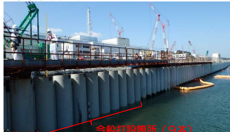
〈鋼管矢板打設完了後〉
