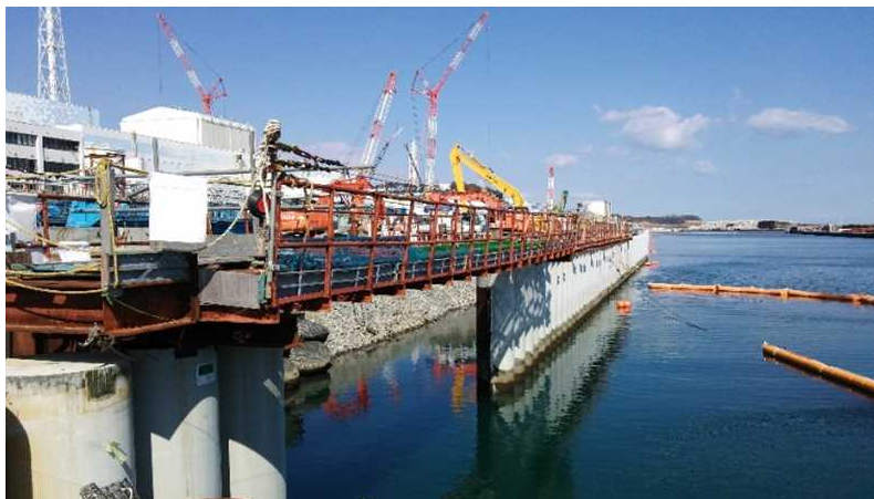
〈鋼管矢板打設前〉
