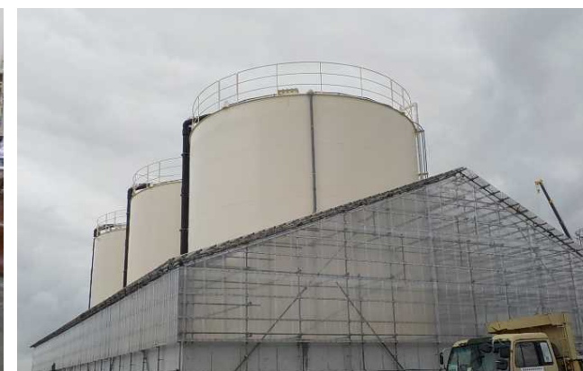
②集水タンク (3基)
