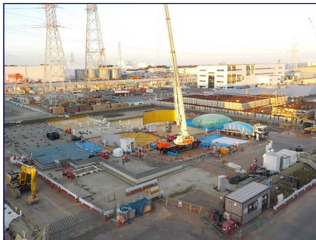
解体中の様子(10月28日撮影)
