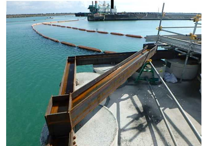
コーナー部における鋼材の補強状況
