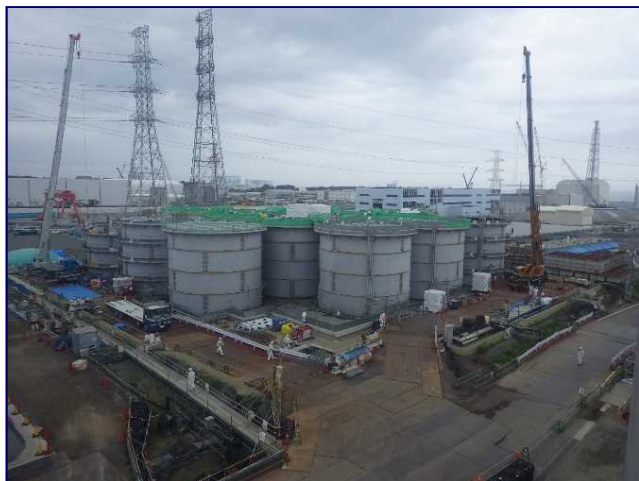
解体開始時の様子(6月19日撮影)
