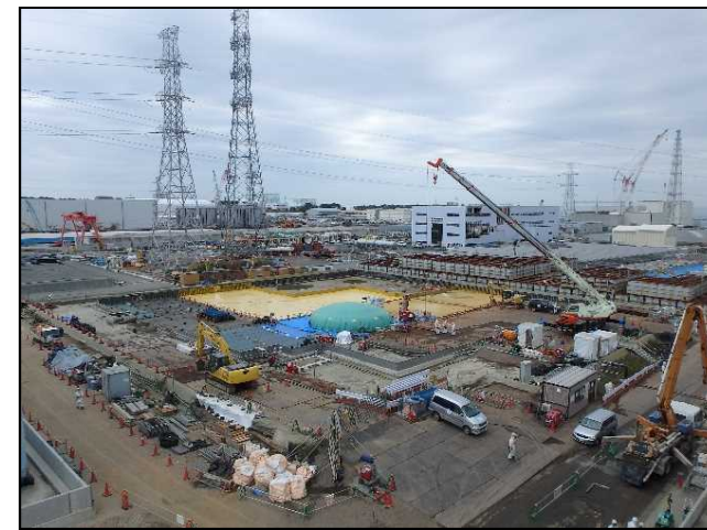
解体後の様子(10月29日撮影)
