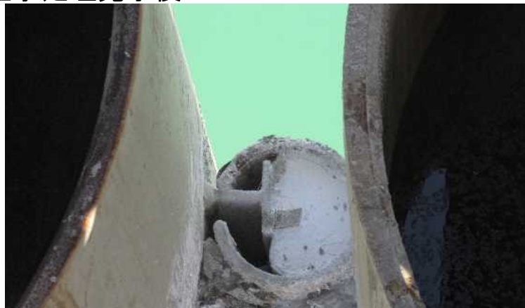
〈継手処理完了後〉
