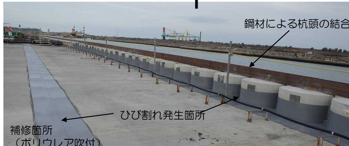
補修実施状況 (ポリウレタ吹付箇所の一例)
