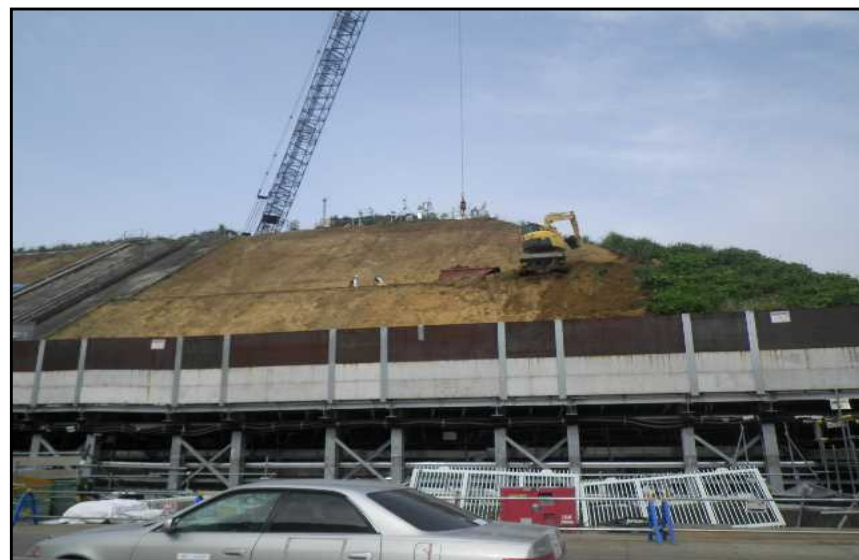
【写真②(35m盤)】1～4号法面:表土剥ぎ取り施工状況
