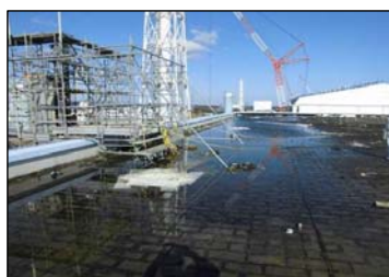
写真②: 2号R/B屋上
