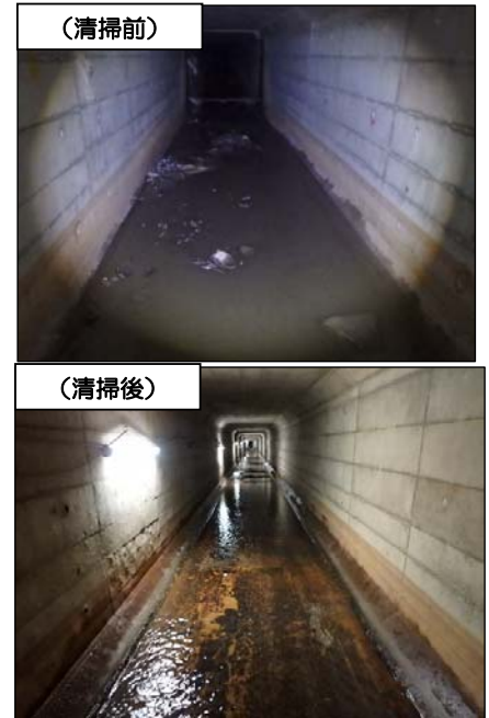
【写真③】K排水路内部
