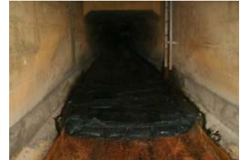
2/10撮影（K排水路）
