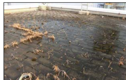
写真④: 大物搬入口屋上
