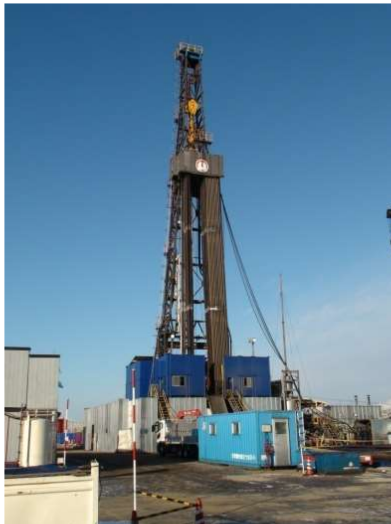
リグ(掘削機械) 高さ:48.50m
