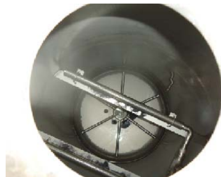
（参考）吸着塔2C内部の様子（腐食なし）
