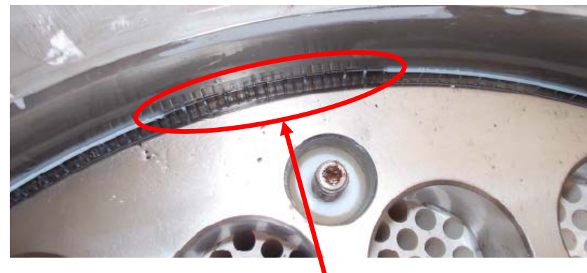
押さえプレート上面より撮影
