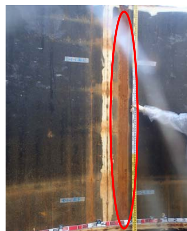
側板1段目 錆の箇所 (平成25年9月19日撮影)
