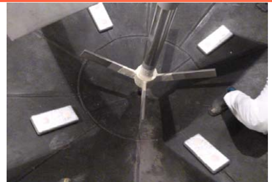
バッチ処理タンク1C (ゴムライニング施工後)
